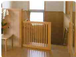
階段に転落防止用の可動式柵を設けるなど、各所に安全対策を施しました。
